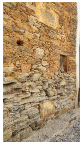
Foto 11. Pormenor da parede exterior.
