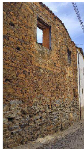
Foto 3. Fachada confinante com via pública.
